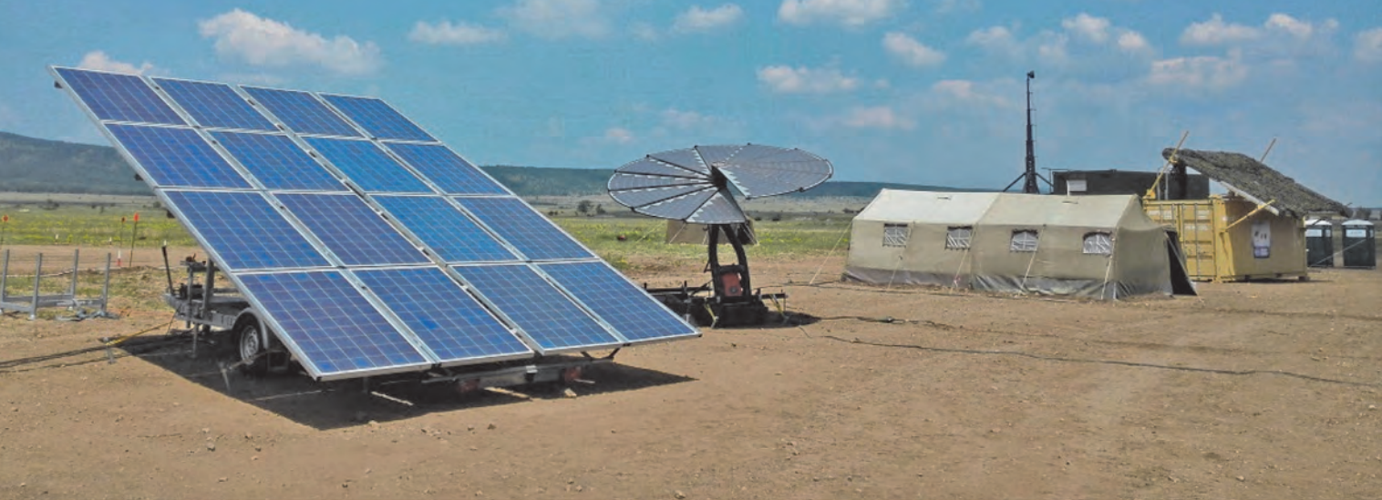
6. ábra. A konvencionálisabb egyszerű és a futurisztikus szolár megoldások tökéletesen kiegészítették egymást. A háttérben látható harmadik panel nem napelem, hanem napkollektor
